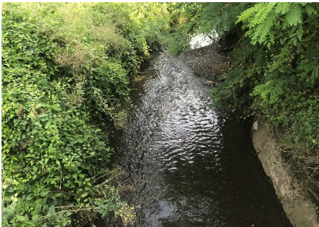
Foto 22: Rio Lovassina nel tratto a valle dell'attraversamento della SR 20. Immagine scattata verso valle da attraversamento della SR 20. L'attraversamento ha sezione rettangolare di larghezza pari a 330 cm ed altezza pari a 200 cm.
