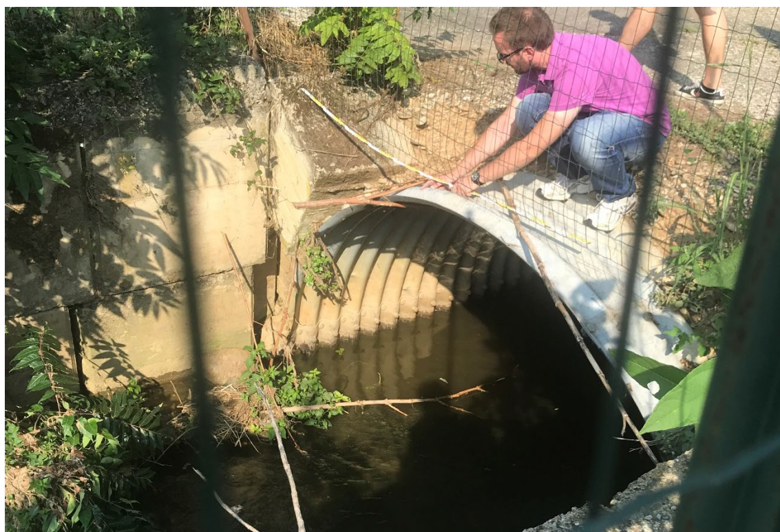
Foto 6: Attraversamento sul Rio Lovassina localizzato poco a valle dello sgrigliatore e realizzato con mezzo TuboSider di diametro pari a 300 cm.
