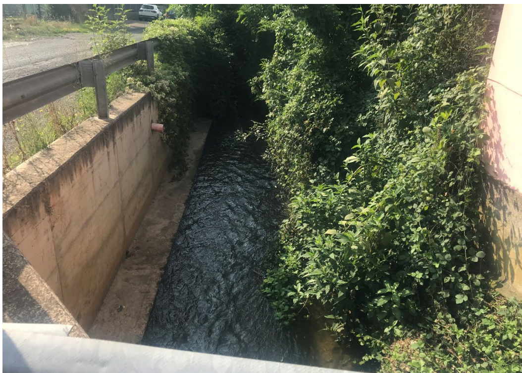
Foto 8: Rio Lovassina nella zona immediatamente a monte del tratto tombinato (foto verso monte). La larghezza della sezione è pari a 400 cm.
