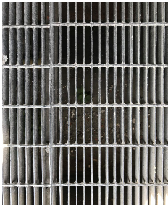
Foto 11 e 12: In corrispondenza delle griglie si rileva la presenza di un collettore di diametro pari a 200 cm; si verifica pertanto in cambio di sezione rispetto a quella di imbocco (Foto 7) da rettangolare a circolare. Si auspica la realizzazione di una video-ispezione al fine di rilevare il punto in cui avviene il cambio di sezione.
