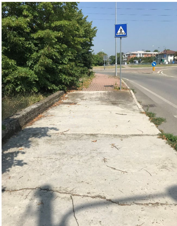
Foto 13 e 14: Tratto intubato del Rio Lovassina in prossimità della rotatoria della SP180. Il tratto intubato si sviluppa al di sotto del marciapiede a lato della SP180; si presume pertanto che la larghezza della sezione sia pari a quella del marciapiede (300 cm). Si auspica la realizzazione di una video-ispezione al fine di rilevare le esatte dimensioni del collettore/scatolare. Foto scattate verso valle (Foto 13) e verso monte (Foto 14).
