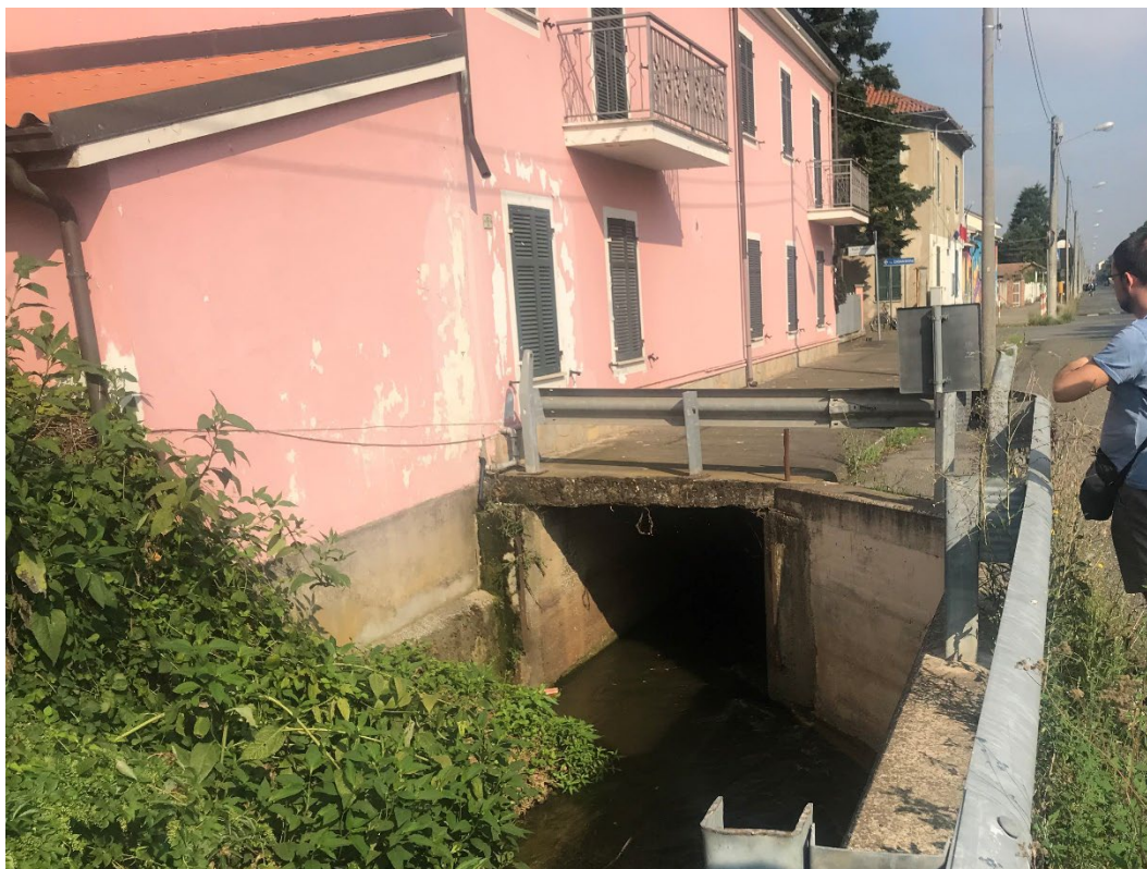
Foto 7: Imbocco del tratto tombinato in corrispondenza dell'abitato di Spinetta Marengo (foto verso valle). La sezione è rettangolare di dimensioni 200 x 200 cm.
